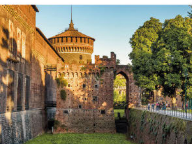
↓ Fig. 15 Il rivellino che protegge la Porta di Santo Spirito del Castello Sforzesco di Milano è l'elemento più avanzato della fortificazione, costruito appena fuori dalle mura a salvaguardia della porta.
